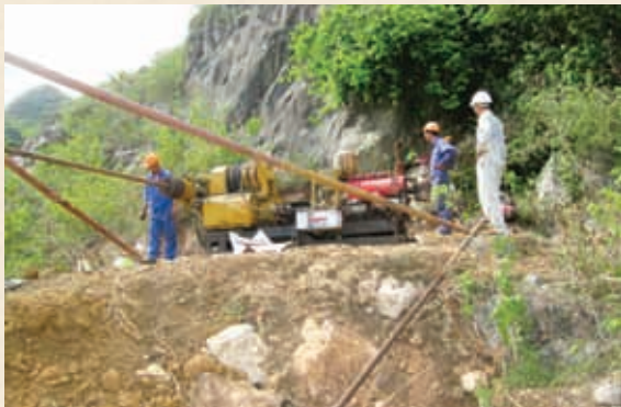
Khoan ngang thẩm đo vật liệu xây dựng xi măng Long Sơn năm 2015
