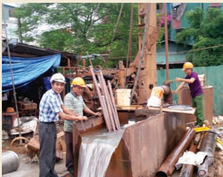
Công trình Nhà máy nước Ngô Sỹ Liên - Hà Nội năm 2015
