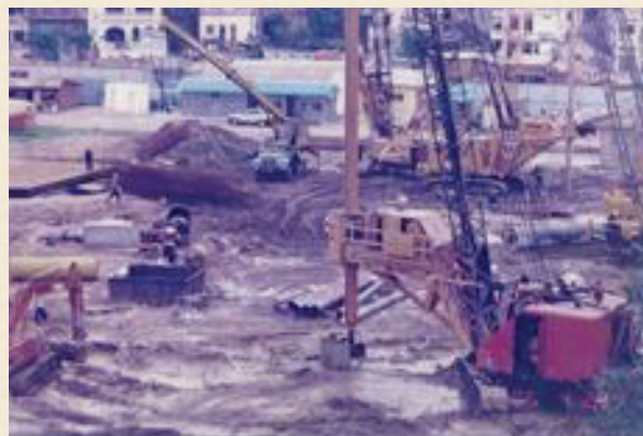
Khoan cọc nhồi 83 Lý Thường Kiệt - Hà Nội năm 1994
