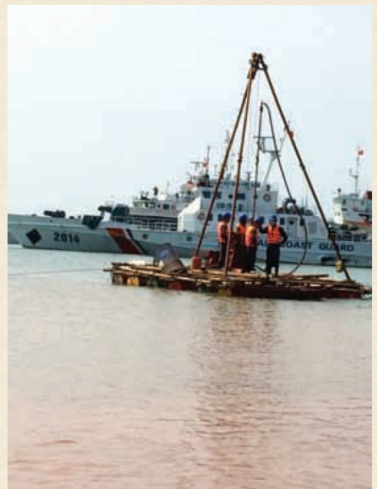
Khảo sát ĐCCT công trình của Cảnh sát Biển Việt Nam tại miền Trung năm 2015
