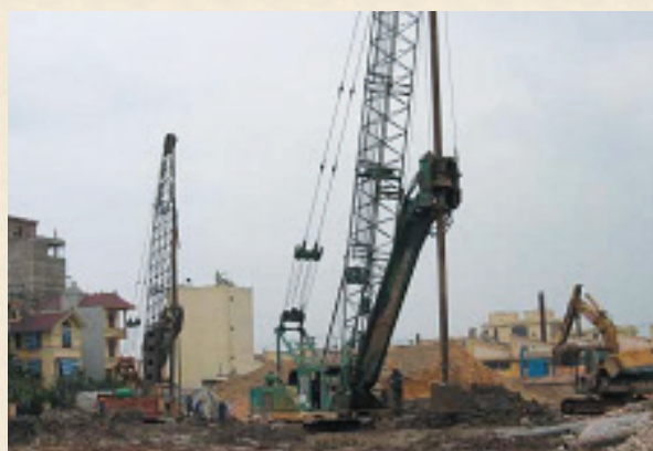
Khoan cọc nhồi trụ sở Viglacera Mễ Trì năm 2003
