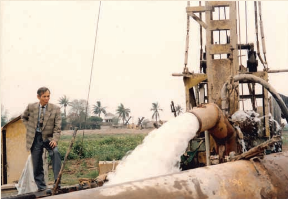
TGD Nguyễn Mạnh Hà kiểm tra công trình cấp nước Gia Lâm năm 1996
