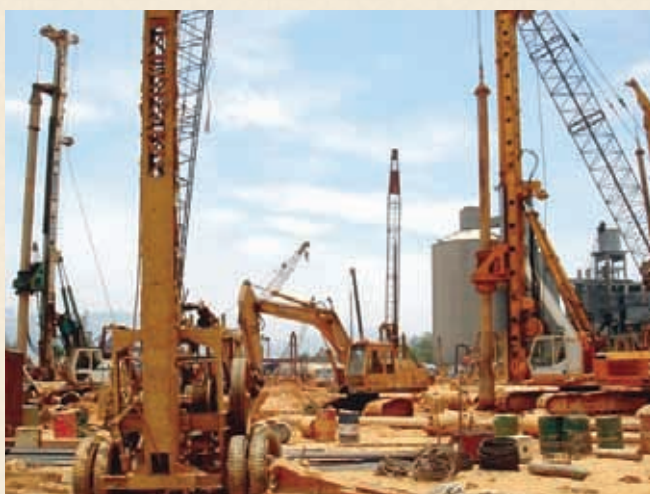
Khoan cọc nhồi nhà máy xi măng Hoàng Thạch dây chuyền III năm 2007
