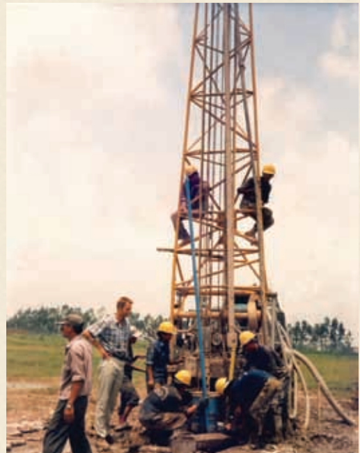
Công trình cấp nước Thường Tín - Hà Tây
