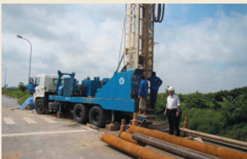
Dự án nước Quang Minh năm 2009
