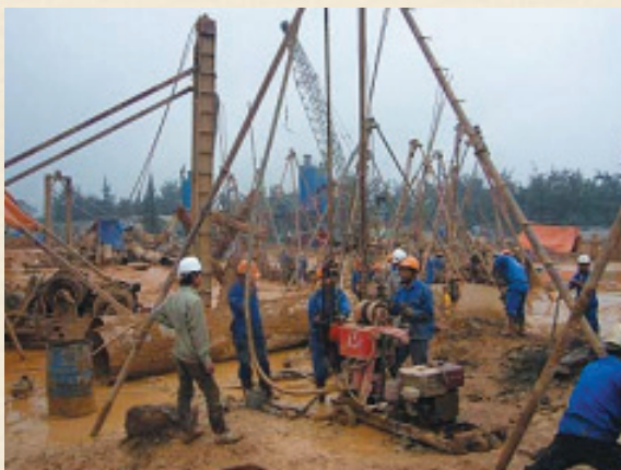
Khoan kiểm tra các tơ công trình Xi măng Hoàng Thạch III năm 2008
