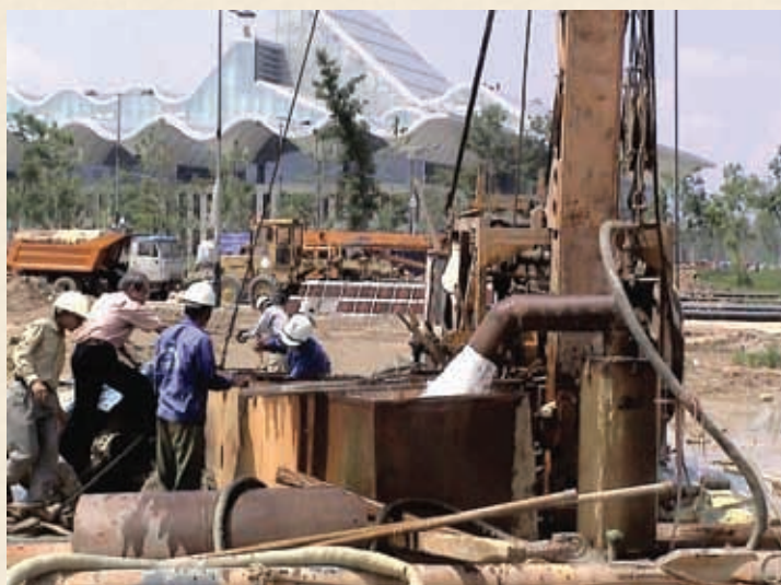
Bơm nước thí nghiệm giếng địa nhiệt Trung tâm Hội nghị Quốc gia năm 2006
